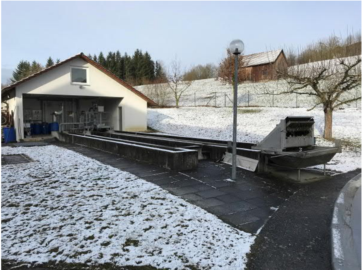
Abbildung 25: Sand- und Fettfang mit Rechen Kläranlage Göggingen-Horn (Weißert 2020)
