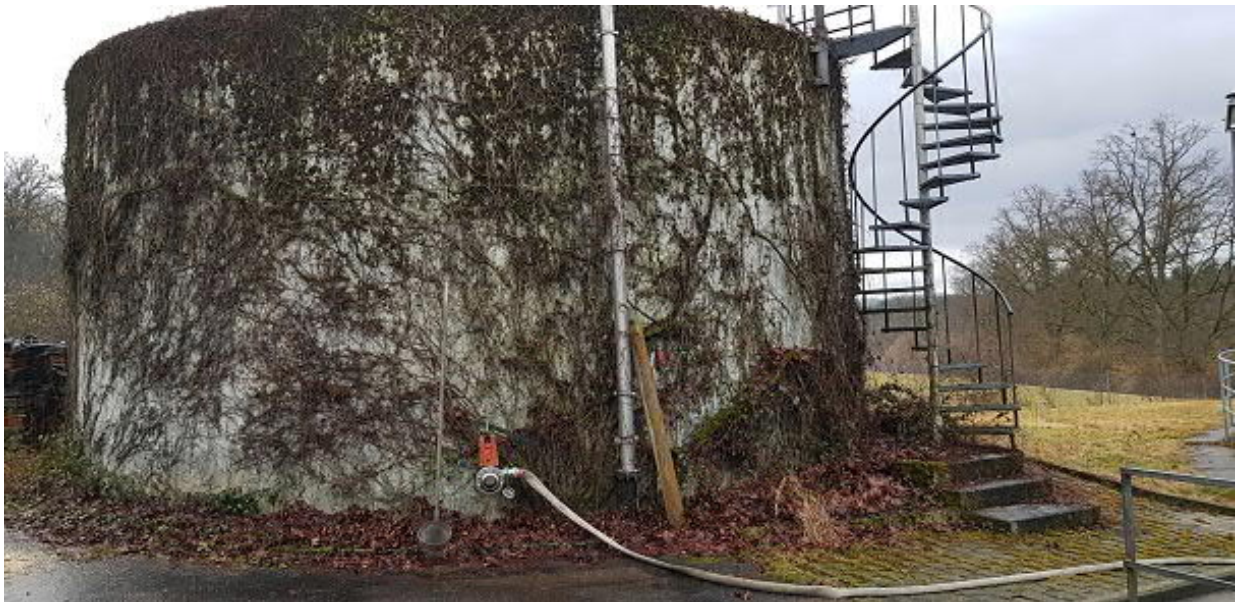
Abbildung 9: Schlamm-silo Kläranlage Schechingen (Weißert 2022)
