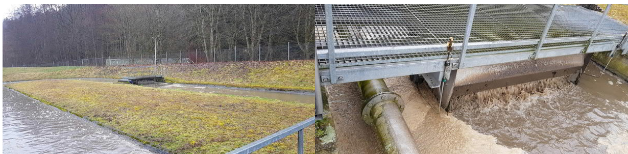
Abbildung 15: Belebungsbecken und Walzenbelüfter der Kläranlage Heuchlingen (Weißert 2022)
