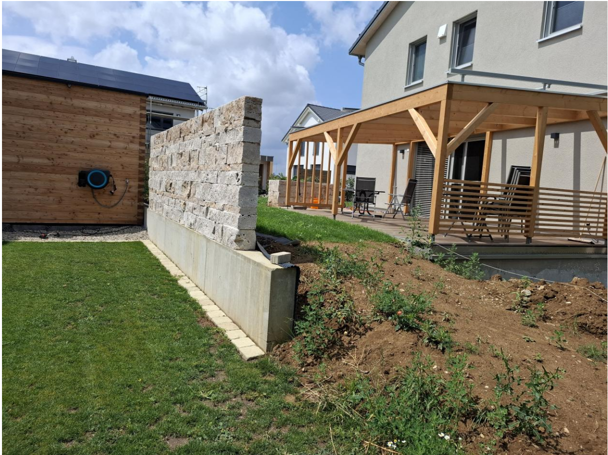
Ansicht Beton-/Natursteinmauer Südseite
