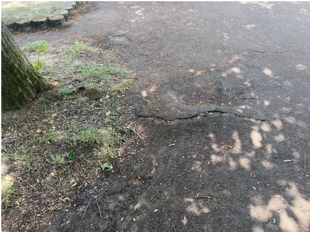
Wurzelwachstum Asphalt
