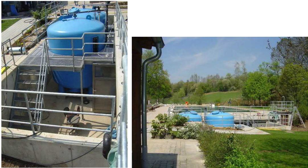
**Abbildung: Filter- Außenaufstellung, Beispiel**
