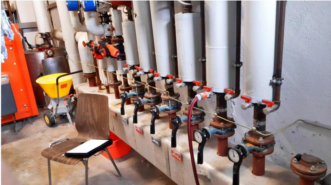
Bei der Verteilung handelt es sich um einen Zweikammer-Heizkreisverteiler über den folgende Heizkreise versorgt werden.
