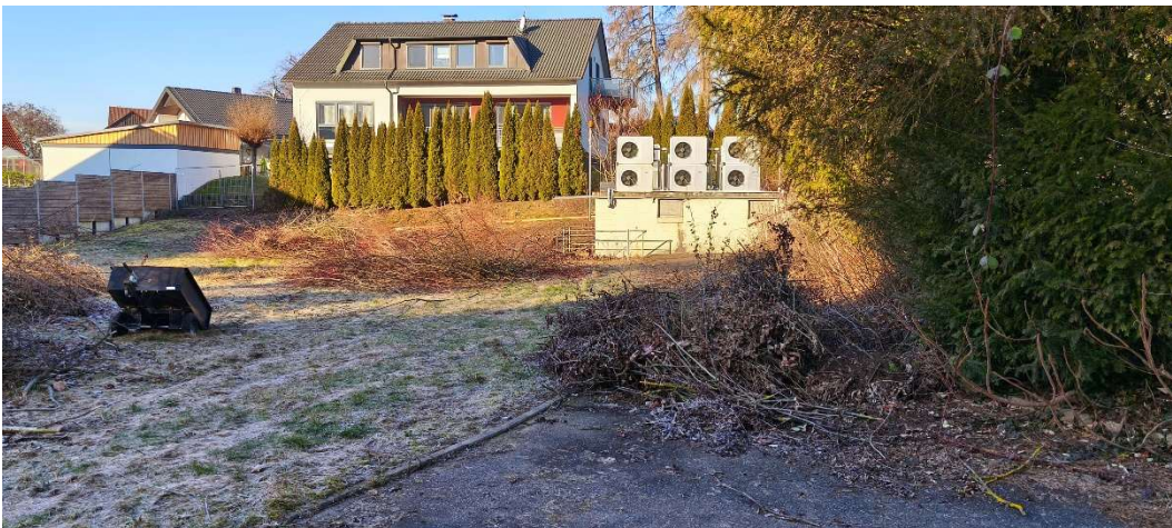
Baufeld und Lagerfläche
